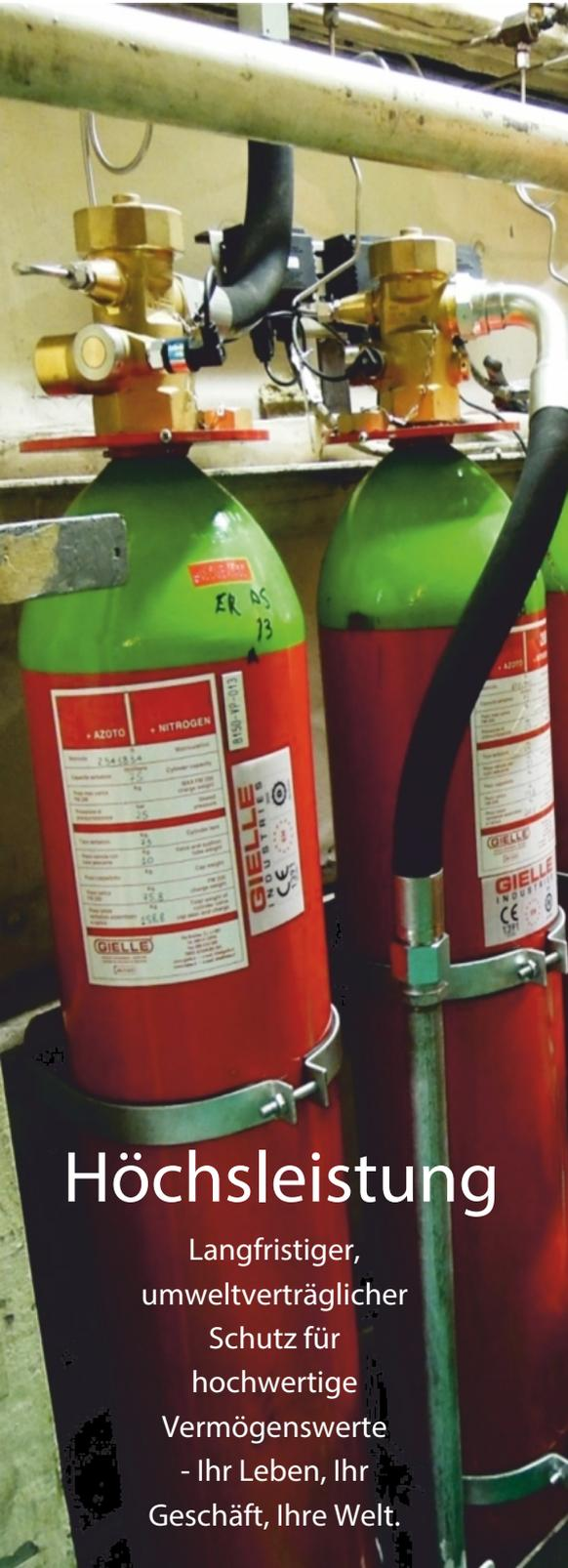
**Gielle GL-1230™ Systeme**, die das 3M™ Novec™ 1230 Flüssiglöschmittel verwenden, zeichnen sich als die beste Lösung für Feuerlöschanlagen zum Schutz von hochwertigen Vermögenswerten und Verfahren ab. GL-1230 ist ein System mit sauberen Löschmitteln, dessen Umweltfreundlichkeit bewiesen ist.
